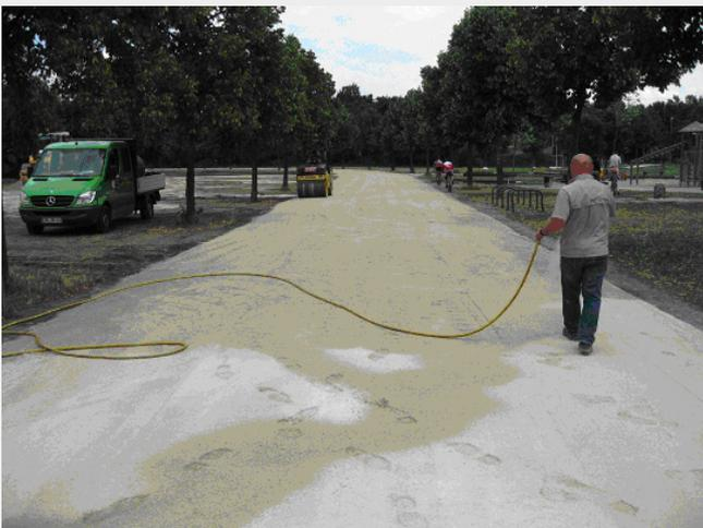
Die Wegedecke wird angefeuchtet und anschließend ange-
