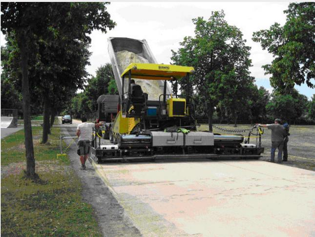
Der Wegebaustoff wird mit dem Fertiger verteilt.
